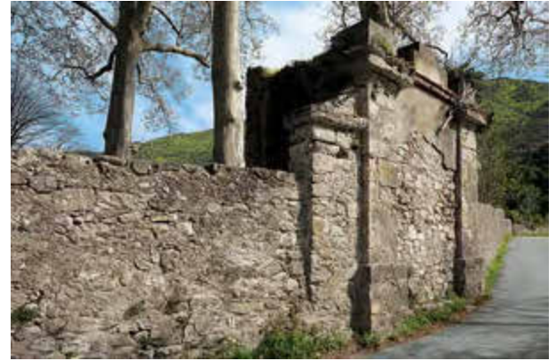
Vue du portail d'accès au parc, aujourd'hui muré, en bordure de l'ancienne route d'Entrevaux à la Seds.
